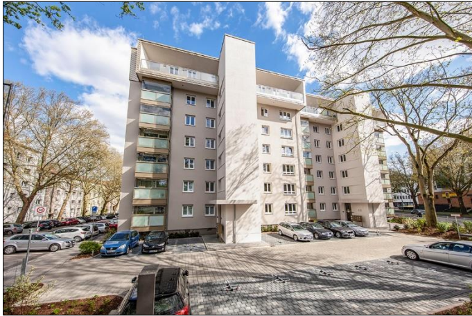
Sanierung und Aufstockung, Niederwaldstraße 46-48, Wiesbaden
