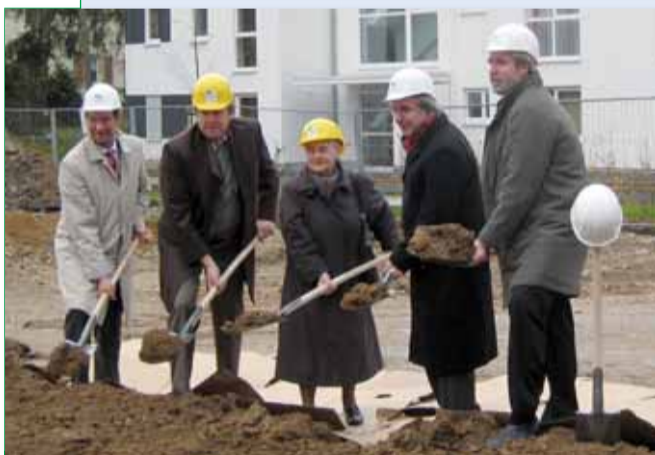
GWW-Geschäftsführer Dr. Mathias Müller, der ausführende Bauunternehmer Bruno Schneider, Anwohnerin Margarete Wawoczny, Oberbürgermeister Dr. Helmut Müller und der leitende Architekt Sever Severain (v.l.n.r.) beim ersten Spatenstich für die neuen, altersgerechten Wohnungen.
