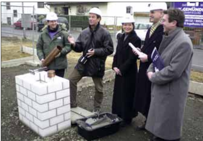
Im Bild (v.l.n.r.): Bauunternehmer Gemünden, GWW-Chef Dr. Müller, Architektin Ingrid Mahler, GWW-Bauleiter Ulrich Odenthal und Rudolf Woller von der Naspä legen gemeinsam den Grundstein.
