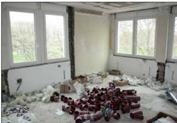
Das Gebäude in der Kronprinzenstraße 28 wird im Zuge der Umbauarbeiten auch technisch auf den neuesten Stand gebracht.
