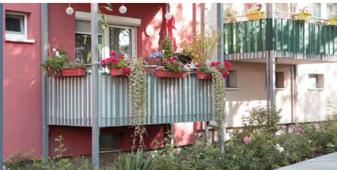
Im Zuge von Sanierungsmaßnahmen erhalten die Wohnungen auch neue Balkone.
