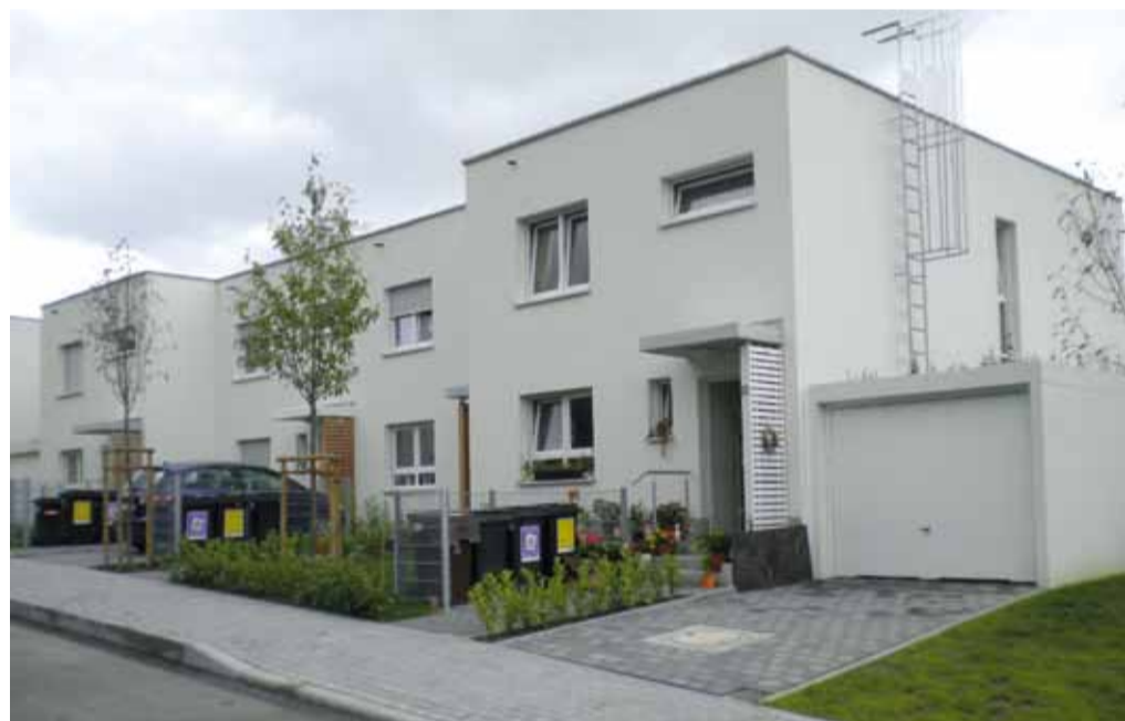
In Wiesbaden-Dotzheim baut die GWW entlang der Sporkhorststraße/Oberer Wingertsweg für junge Familien mit Kindern Einfamilienhäuser in Reihenhausbauweise.
