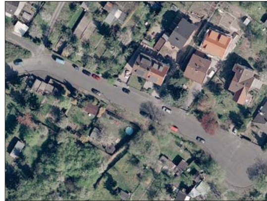
Zum Bestand der GWW gehören auch denkmalgeschützte Häuser. (Bilder ganz links und rechts)
