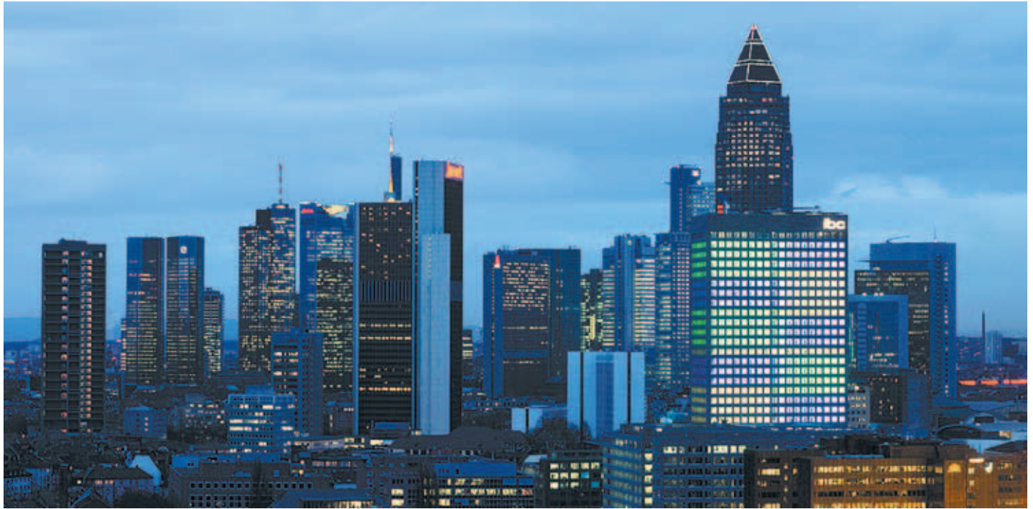
Die Skyline von Frankfurt ist der Stolz einer ganzen Region. Das heißt aber nicht, dass die Bau- und Immobilienwirtschaft deshalb als Leitbranche wahrgenommen wird. Bild: CB Richard Ellis/Kunkel
